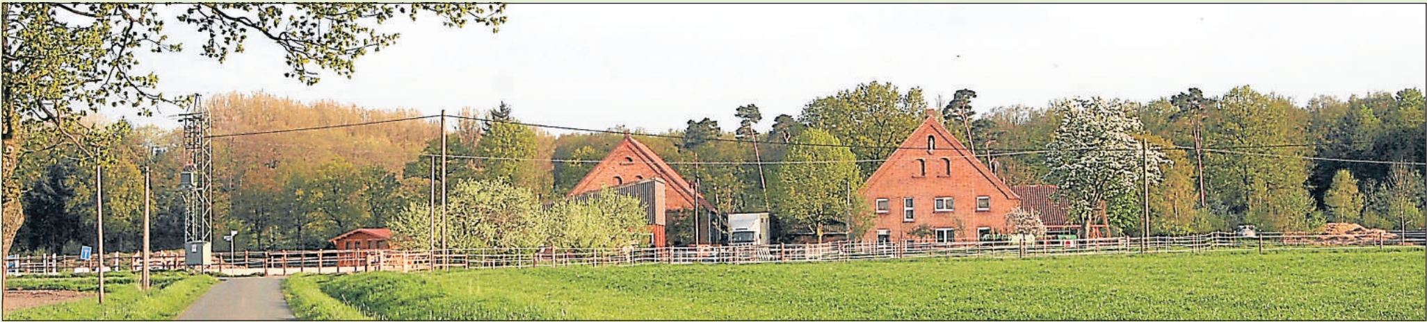
Im Reitstall am Rothenbach gab es Feuchtigkeitsprobleme, als ihn Alexandra Richter erwarb. Dank der fachkundigen Hilfe des Freckenhorster Unternehmens Valexo Bauwerksabdich- tung konnte die Ursache schnell ermittelt werden, und die Profis sorgten dafür, dass das Gebäude optimal abgedichtet wurde.
