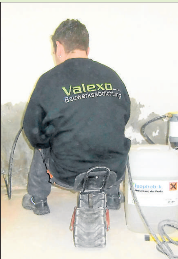
Kompetent und mit den richtigen Produkten sorgen die Mitarbeiter der Valexo Bauwerksabdichtung da- für, dass Feuchtigkeit kein Problem mehr ist.
